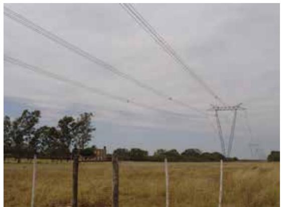
**Figura 5.24.** Línea de Extra Alta Tensión (500 kV), con franja de servidumbre de 100 metros totalmente despejada.
