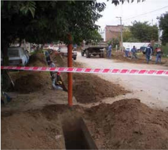
**Figura 5.4.** Excavación en vereda para enterramiento de ductos de cloacas. En este caso se observa la coincidencia con la línea de alumbrado público y el alejamiento de la línea de arbolado.
