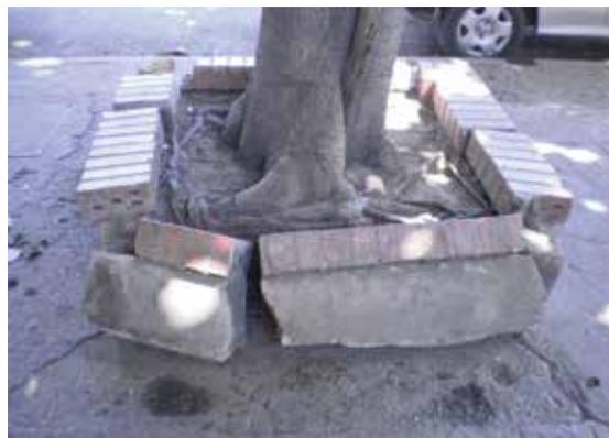
**Figura 4.7.** Las tazas elevadas no tienen ningún beneficio para el árbol y suelen terminar rotas por la presión de tronco y raíces. En este caso el daño está acelerado e incrementado por que se ha plantado una especie de ficus (*Ficus lyrata*).
