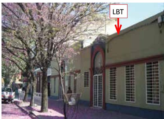
**Figura 5.21.** Línea de Baja Tensión (LBT) pre-ensamblada mimetizada instalada sobre la fachada de un edificio.
