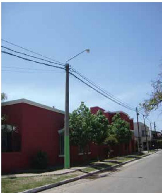
**Figuras 5.7.** Diversidad de servicios compartiendo columnas. En la foto se observan: telefonía, video cable, energía eléctrica y alumbrado público. Ver detalles de ubicación en la Figura 5.19.
