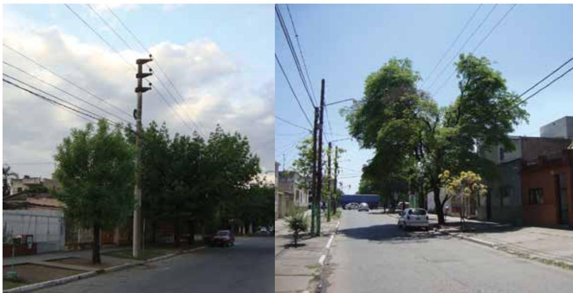
**Figura 5.18.** Líneas de Media Tensión de 33 kV coplanar vertical. A la izquierda se observa que la columna se comparte con otros servicios. En ambos casos se observa la intervención en árboles de mediano y gran porte.
