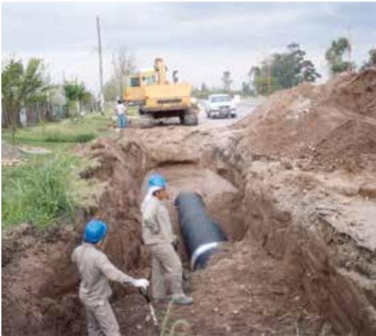
**Figura 5.5.** Excavación para colocación de un colector principal de red de cloacas por la calzada, que evidencia la magnitud de la obra.
