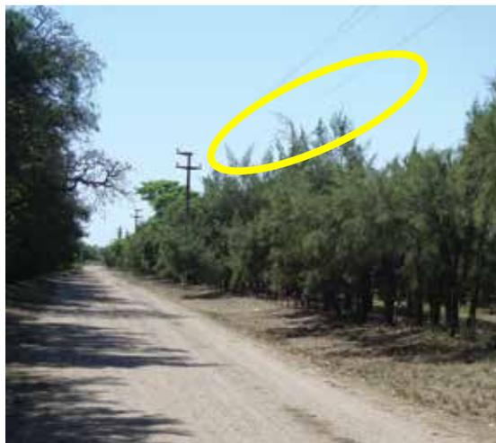
**Figura 5.13.** Zona de interacción entre el tendido eléctrico y la pantalla forestal de casuarinas en una finca en el Este de Tucumán.
