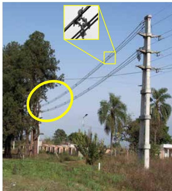
**Figura 5.14.** Zona de interacción entre una línea de Media Tensión (33 kV), compacta protegida, doble terna en proximidad con pantalla forestal de eucaliptos en la Ruta Provincial 301.
