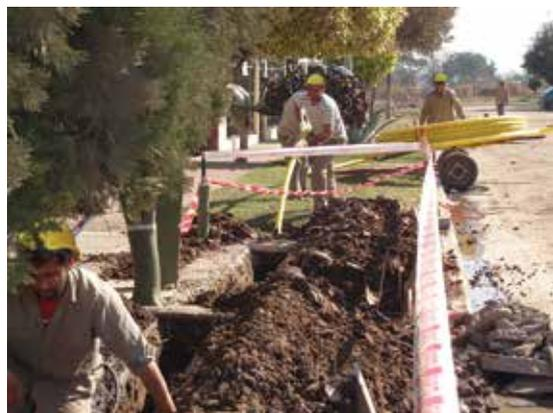
**Figura 5.3.** Tendido de una red de gas de media presión por vereda.
