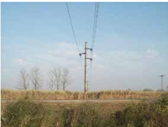
**Figuras 5.23.** Línea de Alta Tensión (132 kV), cuya franja de servidumbre cuenta con plantación de cañaverales. Las prácticas de quema, durante la época de cosecha suelen ocasionar interrupciones.
