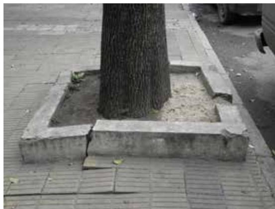
**Figura 4.6.** Taza elevada dañada por el crecimiento de un fresno.
