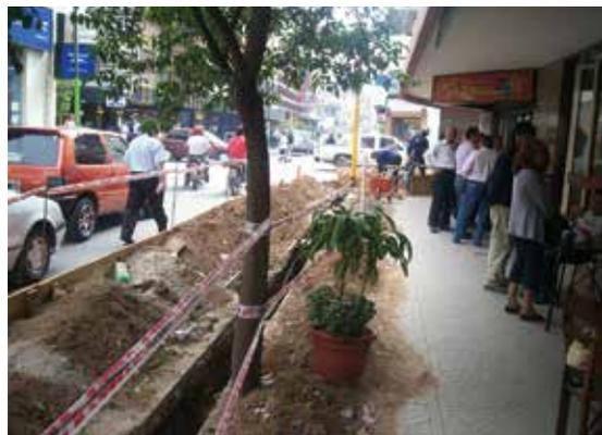
**Figura 5.9.** Tendido de líneas eléctricas subterráneas de Media Tensión en zona céntrica de la ciudad de San Miguel de Tucumán. Se observa coincidencia con la línea de arbolado y alumbrado público.
